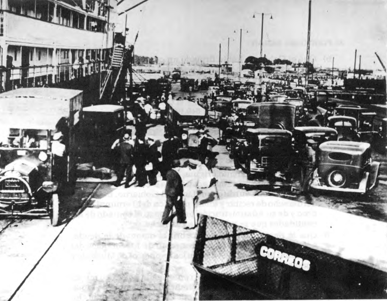
Terminal marítimo del Callao. Vista del muelle Nº 1 en 1936, mostrando la atención a un buque de carga, correo y pasajeros de la época, perteneciente a la Compañía Peruana de Vapores. (Archivo Fotográfico ENAPU).
