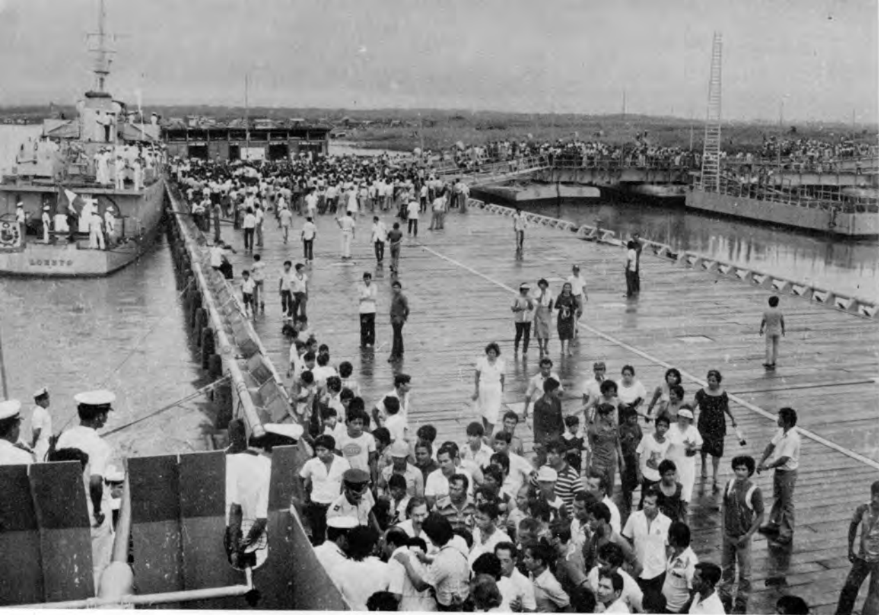
Terminal fluvial de Pucallpa. Muelle y puente basculante en plena visita por personas del lugar a nuestros buques de la Armada. (Archivo Fotográfico ENAPU).
