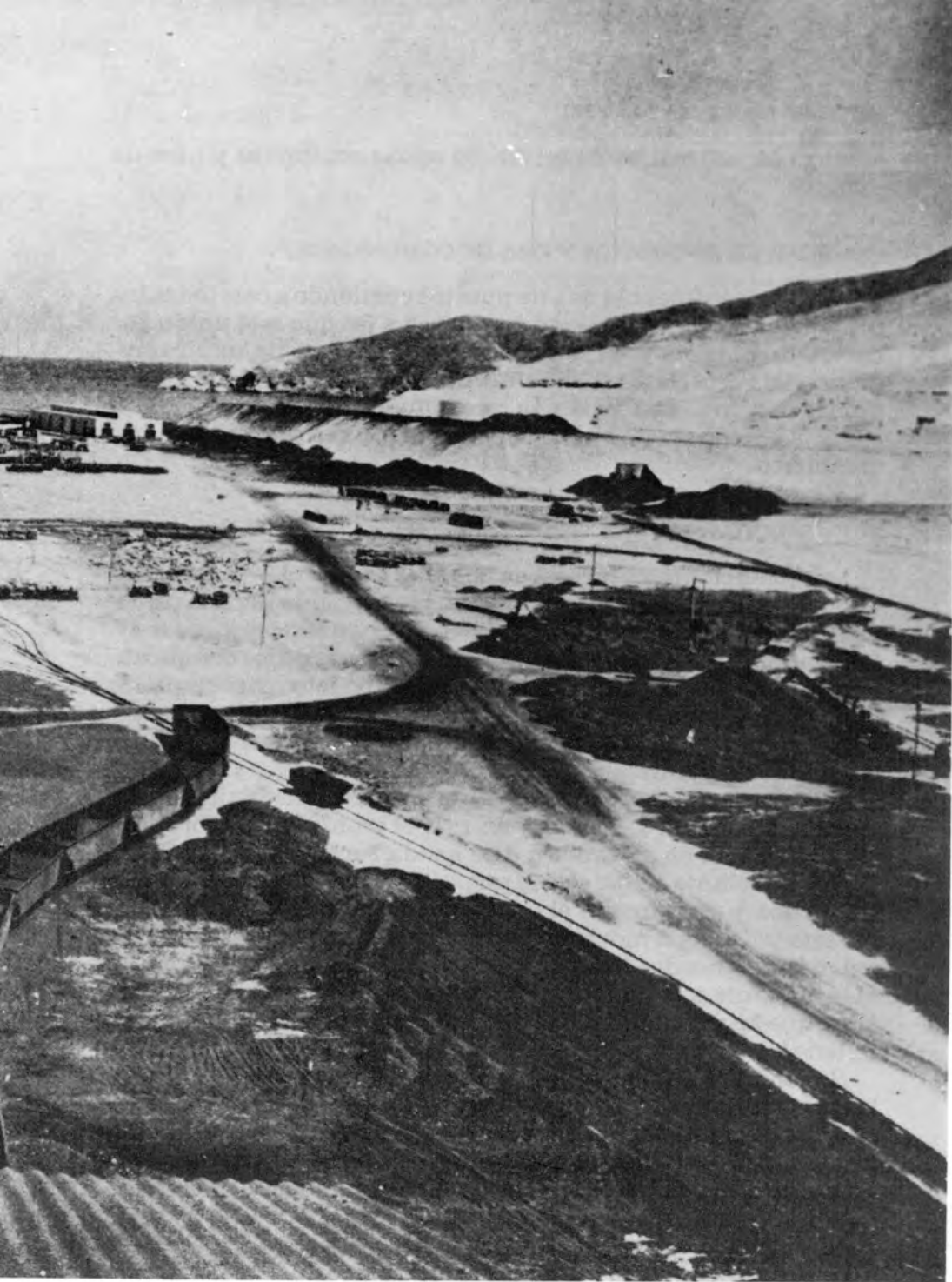
Chimbote. Una vista de la zona portuaria e industrial, en ella puede apreciarse el terminal marítimo que cuenta con un muelle de 980 metros de longitud, permitiendo el acoderamiento de barcos de 30 pies de calado. (Reproducido de Manuel A. Odria y el Progreso del Perú ).
