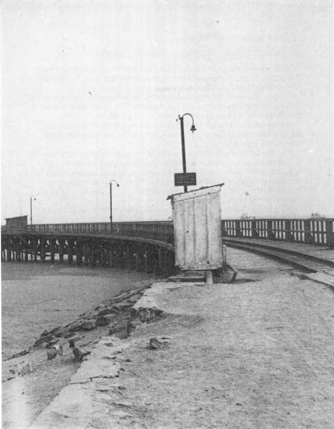
Vista del muelle de Puerto Chicama, cuya longitud es de 823 metros de largo. (Archivo Fotográfico ENAPU).
