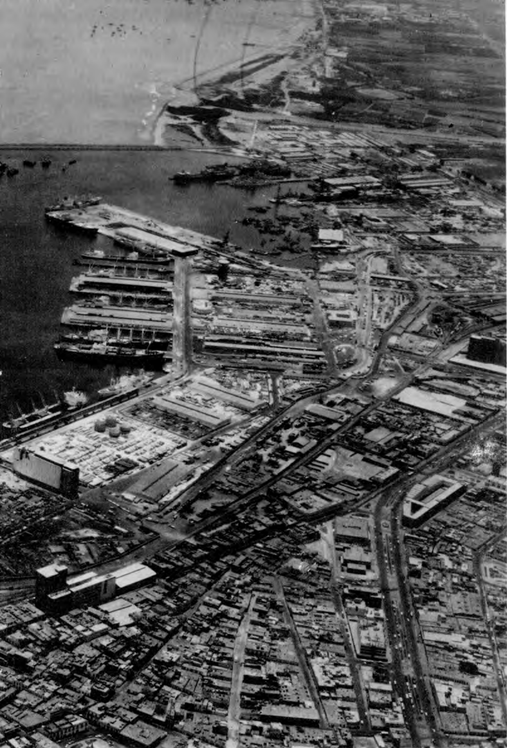
Otra vista aérea del terminal marítimo del Callao, mostrando tres ampliaciones efectuadas por la ex-Autoridad Portuaria del Callao: el muelle de minerales, el de petróleo y el del ex-dársena. (Archivo Fotográfico ENAPU).
