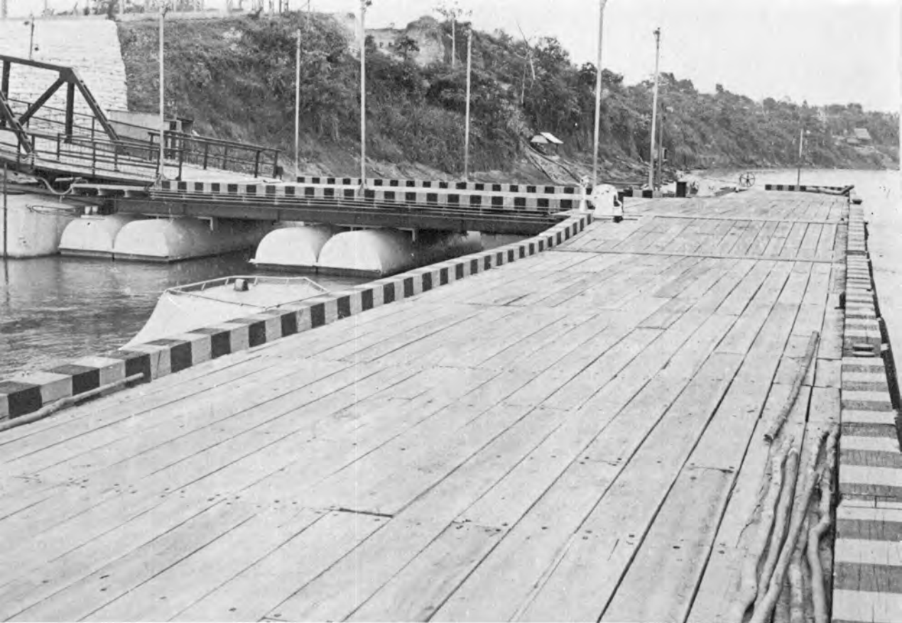
Terminal fluvial de Yurimaguas. Muelle y puente basculante. (Archivo Fotográfico ENAPU).
