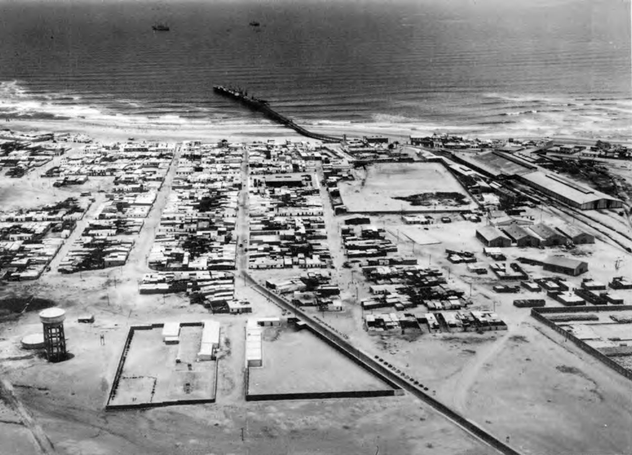
Pimentel. Vista panorámica del muelle y la ciudad. (Archivo Servicio Aerofotográfico Nacional).
