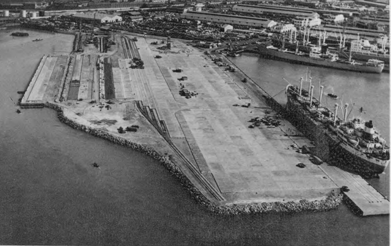
El muelle de minerales al iniciar sus operaciones en 1968. Se dejó sin cuadrar la parte frente al dique y gradas de construcción del SIMA, hasta comprobarse que no constituía peligro para el lanzamiento de naves. (Archivo Fotográfico ENAPU).
