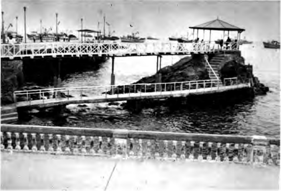
Glorieta que se encuentra cerca al antiguo muelle.
