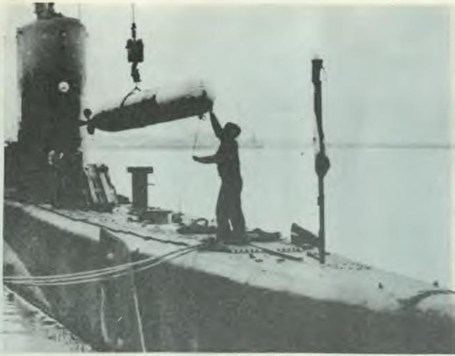
SE INICIA LA FAENA de embarque de torpedos en el muelle de submarinos. Suspendido por un winche, el torpedo se coloca sobre el plano de embarque de estos mortíferos proyectiles
