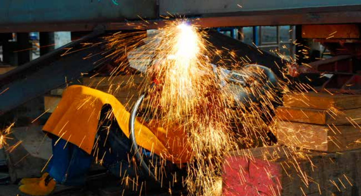
Personal del SIMA, realizando trabajos de soldadura.
