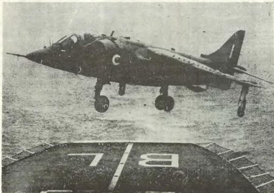
Un caza Hawker Siddeley VTOL (de despegue y aterrizaje vertical) aterriza en la cubierta del crucero HMS **Blake** durante unas pruebas. El **Harrier** tiene una envergadura de 7,70 metros y una velocidad máxima de 1186 k.p.h. Los nuevos cruceros de «cubierta continua» de la Real Marina de Guerra, todavía en etapa de proyecto, serán apropiados para este avión y para helicópteros.
