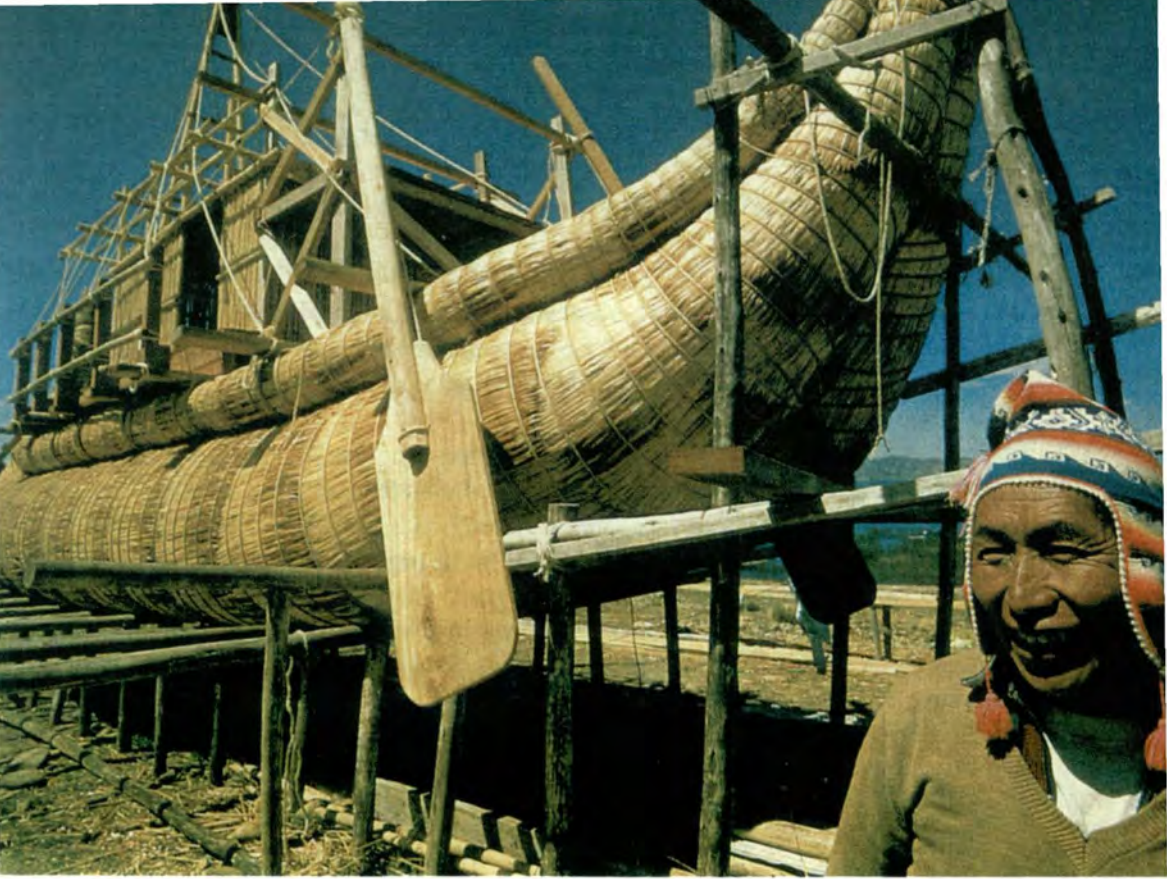
Construcción de una balsa de totora en Puno. (Cortesía PERÚ FOTOSTOCK S.A.).
