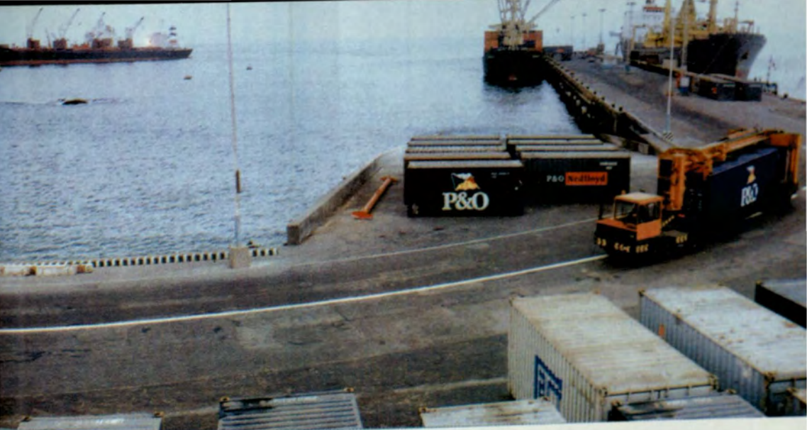
Terminal portuario de Ilo.
