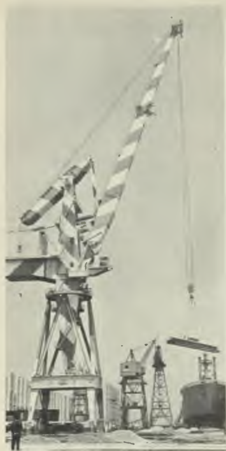
El SIMA cuenta actualmente con dos gigantescas grúas, con una capacidad de operación hasta de 45 toneladas de carga.
