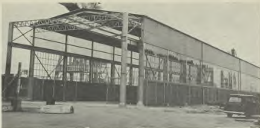
El nuevo taller de tuberías. Se está procediendo a su equipamiento de máquinas.
