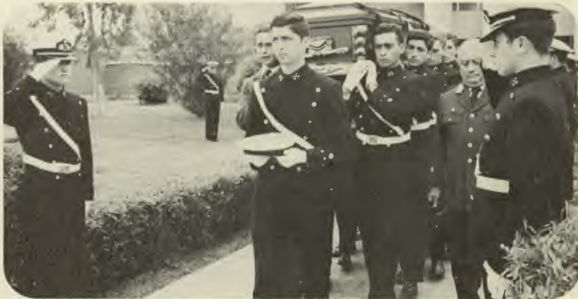
EL ULTIMO SISMO , ocurrido el 3 de Octubre, cobró una víctima en nuestras filas. Una de las paredes de la Escuela Naval se desplomó y como consecuencia de este derrumbe perdió la vida el cadete Vladimir Mejía Coppo. La foto muestra el instante en que, con mucho pesar, familiares y amigos acompañan al citado cadete hasta su última morada.
