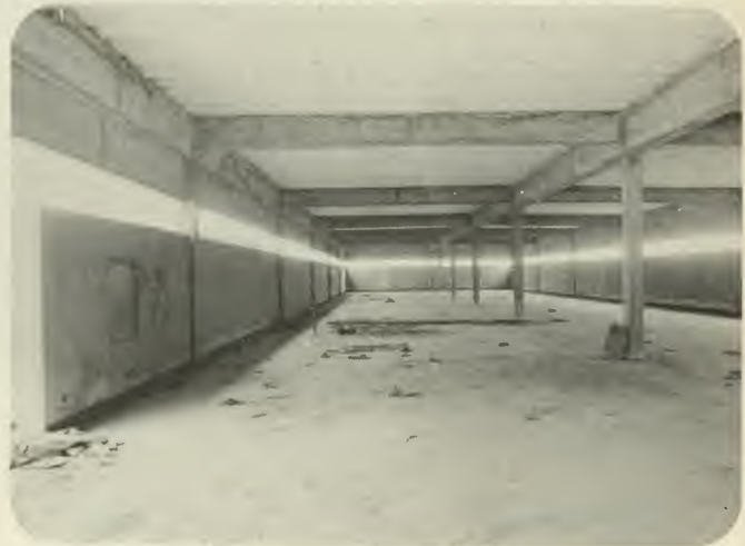
SE ESTAN DANDO LOS ULTIMOS TOQUES a los Almacenes del Complejo del Servicio de Bienestar.
