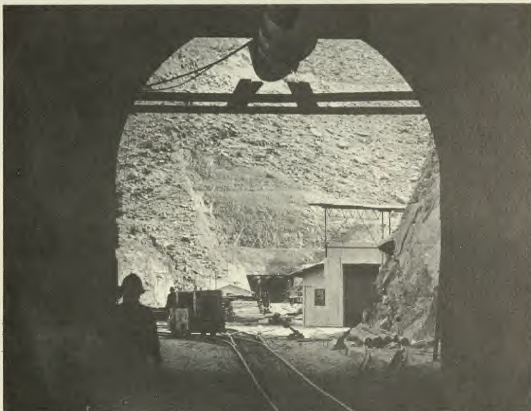
VISTA DE UNA DE LAS ENTRADAS DE LA RED DE TUNELES
