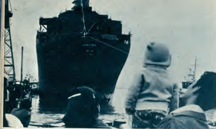
SE LANZA AL MAR EL GRANELERO "AMAZONAS", el tercer granelero de 25,200 toneladas que se construye en el SIMAC ( 25 Julio ).
