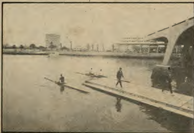
Modernas instalaciones y edificios de la Escuela Naval del Perú.
