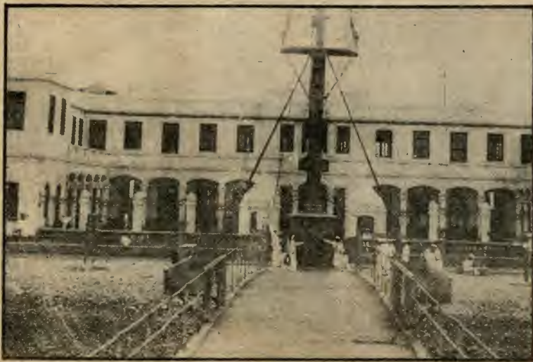
Edificio de la antigua Escuela Naval. Foto tomada el año 1945.
