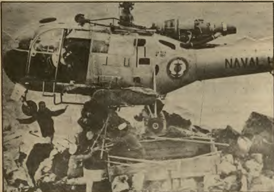
Un helicóptero naval en una arriesgada operación. En sucesivos vuelos, logran el encofrado para la base del faro, en la cima del islote "Pelado".
