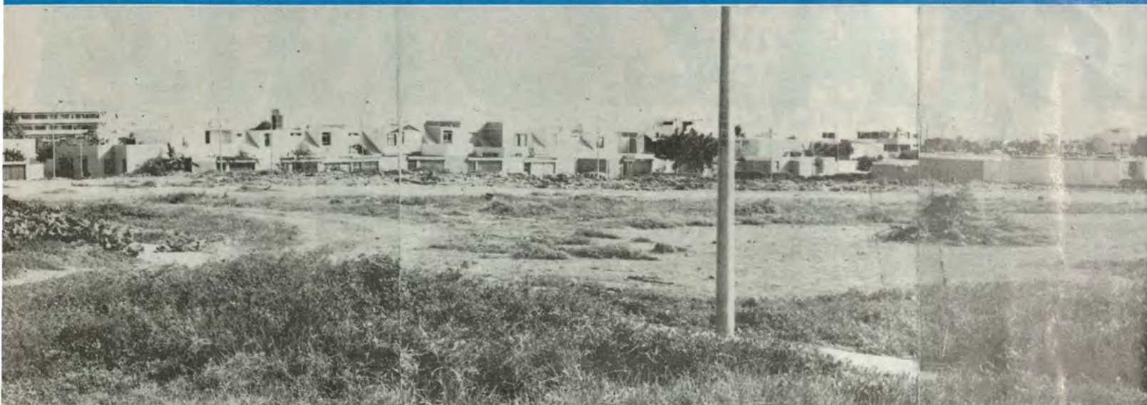
Vista panorámica del terreno donde se construiría un anexo del Liceo Naval "Teniente Clavero"
