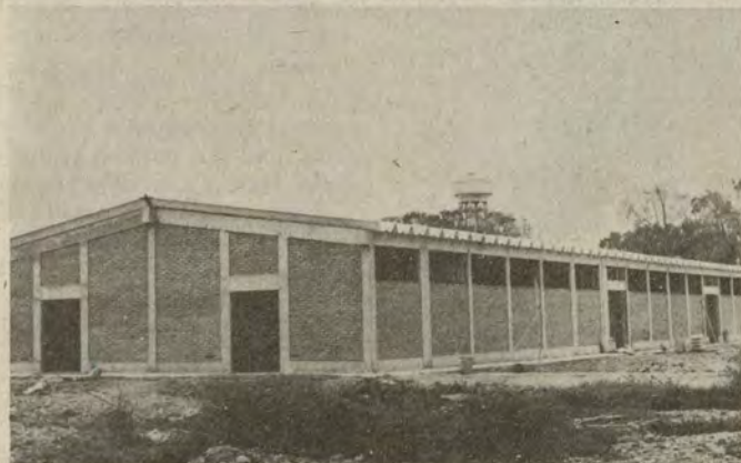
Parte de la construcción de pabellones para alojamiento del personal subalterno que labora en el Centro Médico Naval.
