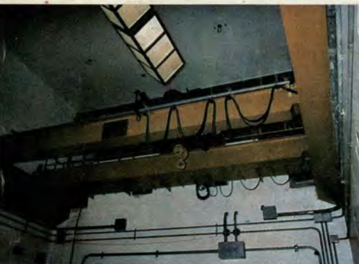
Grúa-puente construido por el SIMA para el IPEN.
