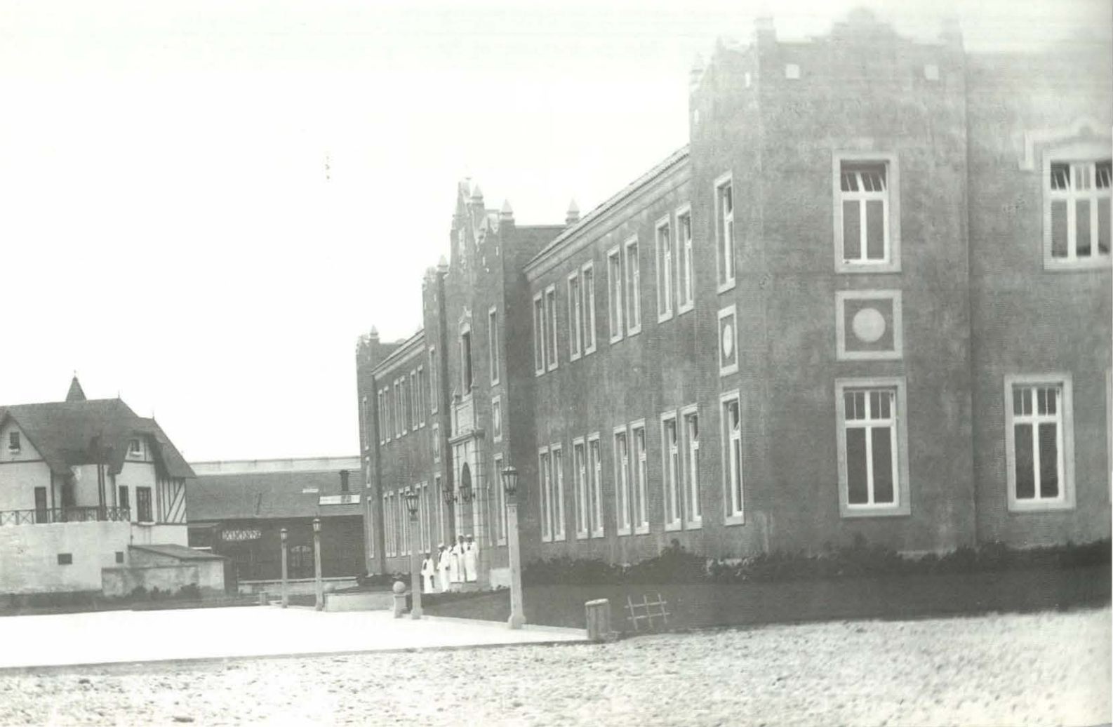
Vista sureste del edificio San Martín
