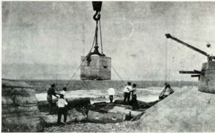
Una grúa coloca un macizo block para formar el rompeolas que permitió a La Perla tener una playa.
