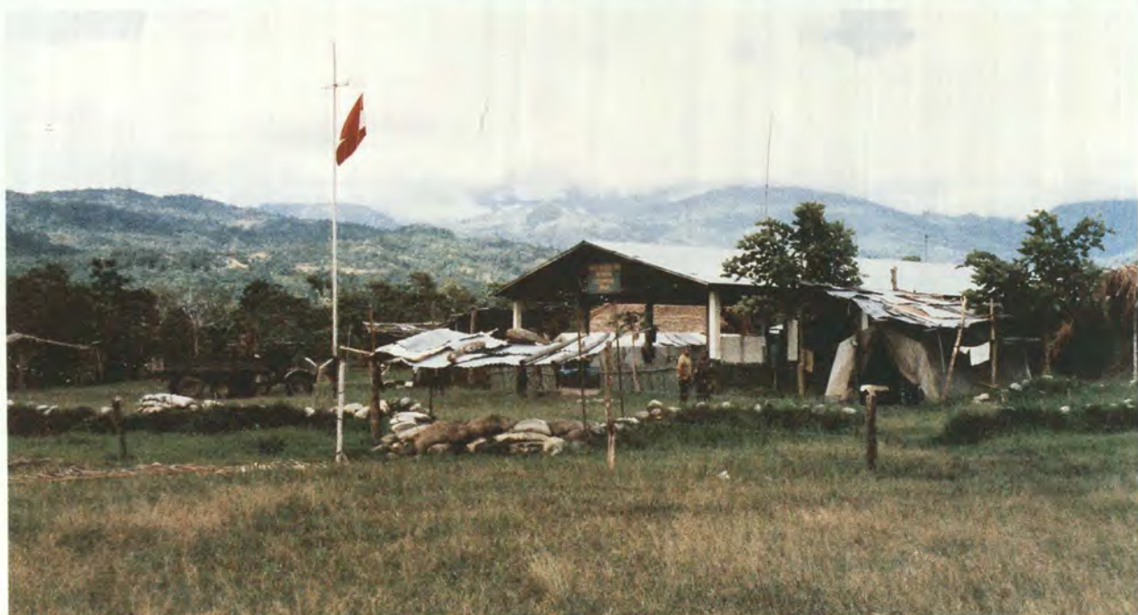
Vista de la BCS Luisiana al pie de la pista de aterrizaje
