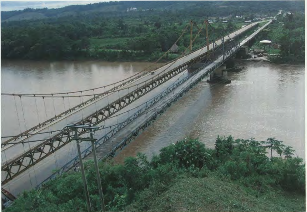
Puente sobre el río Aguaytía; puente colgante de 800 m (el más largo del Perú) en la carretera Federico Basadre entre las ciudades de Tingo María y Pucallpa.
