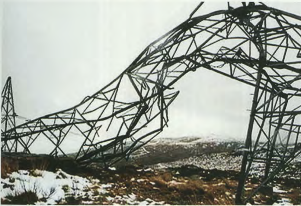
Torre de alta tensión destruida por Sendero Luminoso. Foto: Profesor José Godoy
