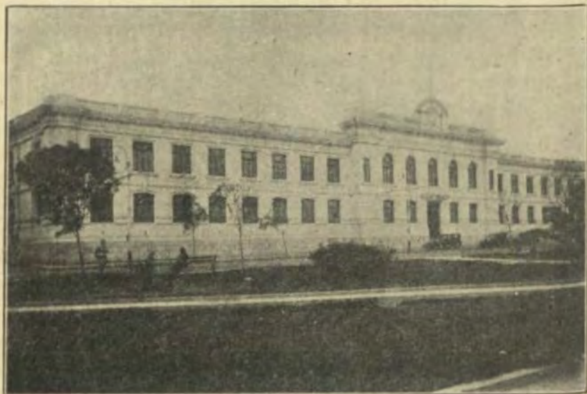
Edificio del Ministerio de Justicia e Instrucción
