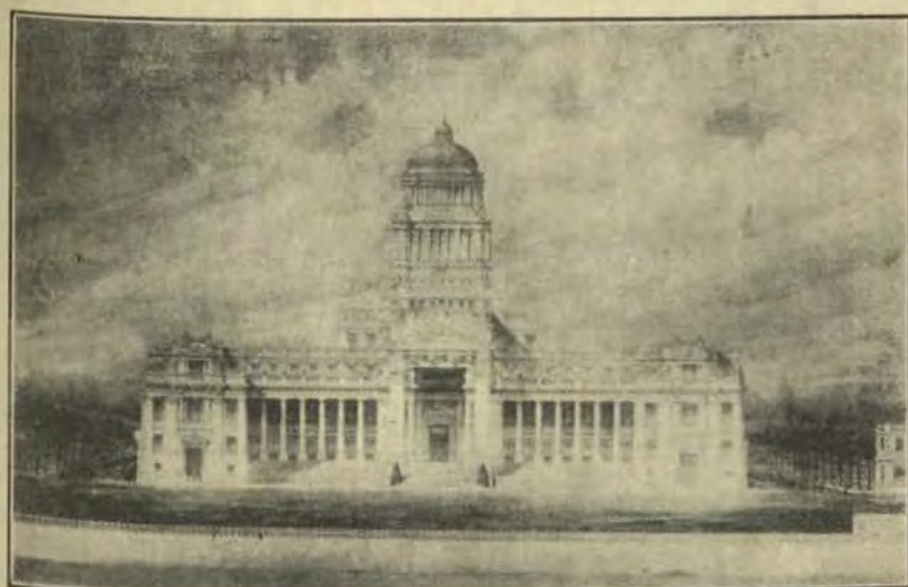
Palacio de Justicia en construcción
