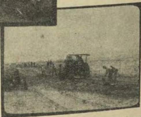
Aplanadora de 6 Ton. ro- dillando la calzada. Camino a Chicha
