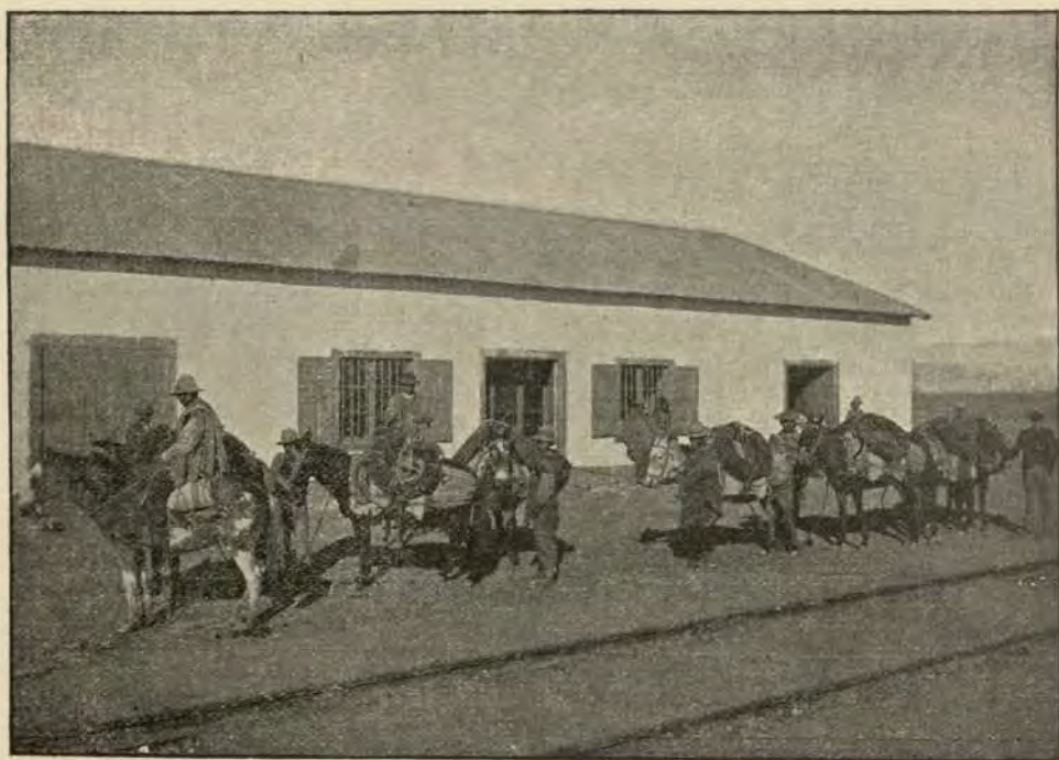
TIRAPATA—Transporte de cables de 4.000 piés de largo para un puente de la Inca
