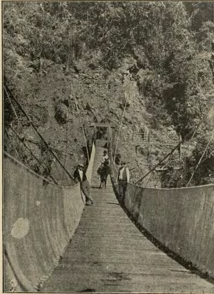
Puente de la Oroya en el Inambari, construido por la Inca Minning C.º
