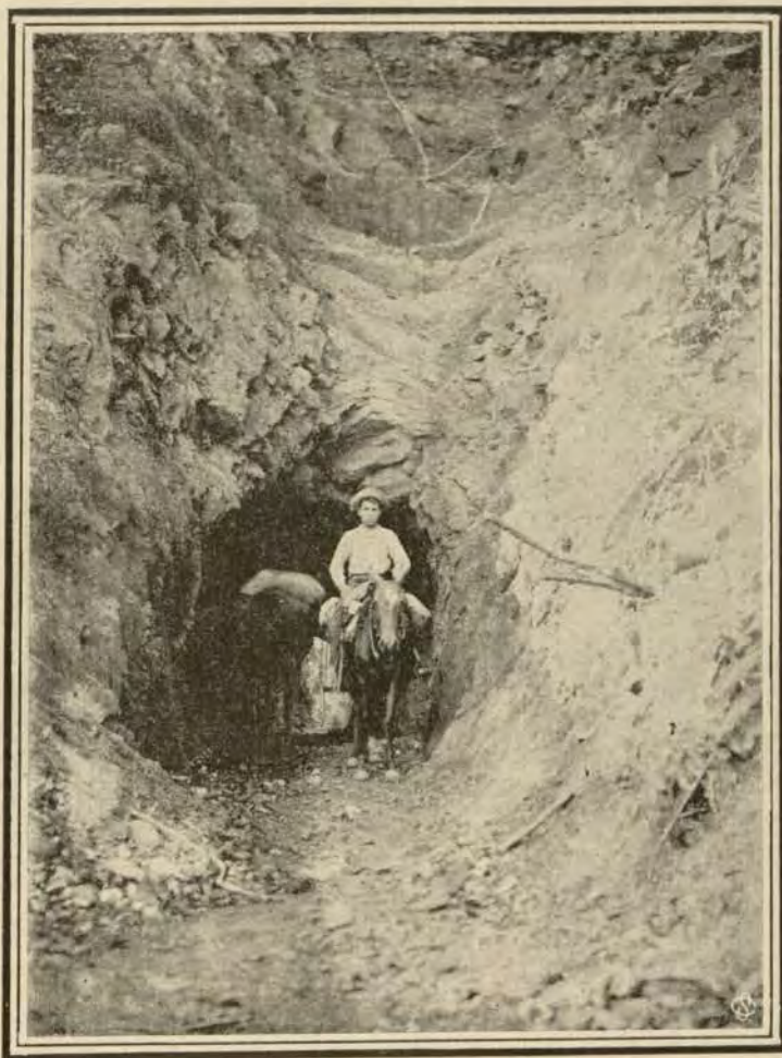
Túnel en el camino de la Inca Rubber Company
